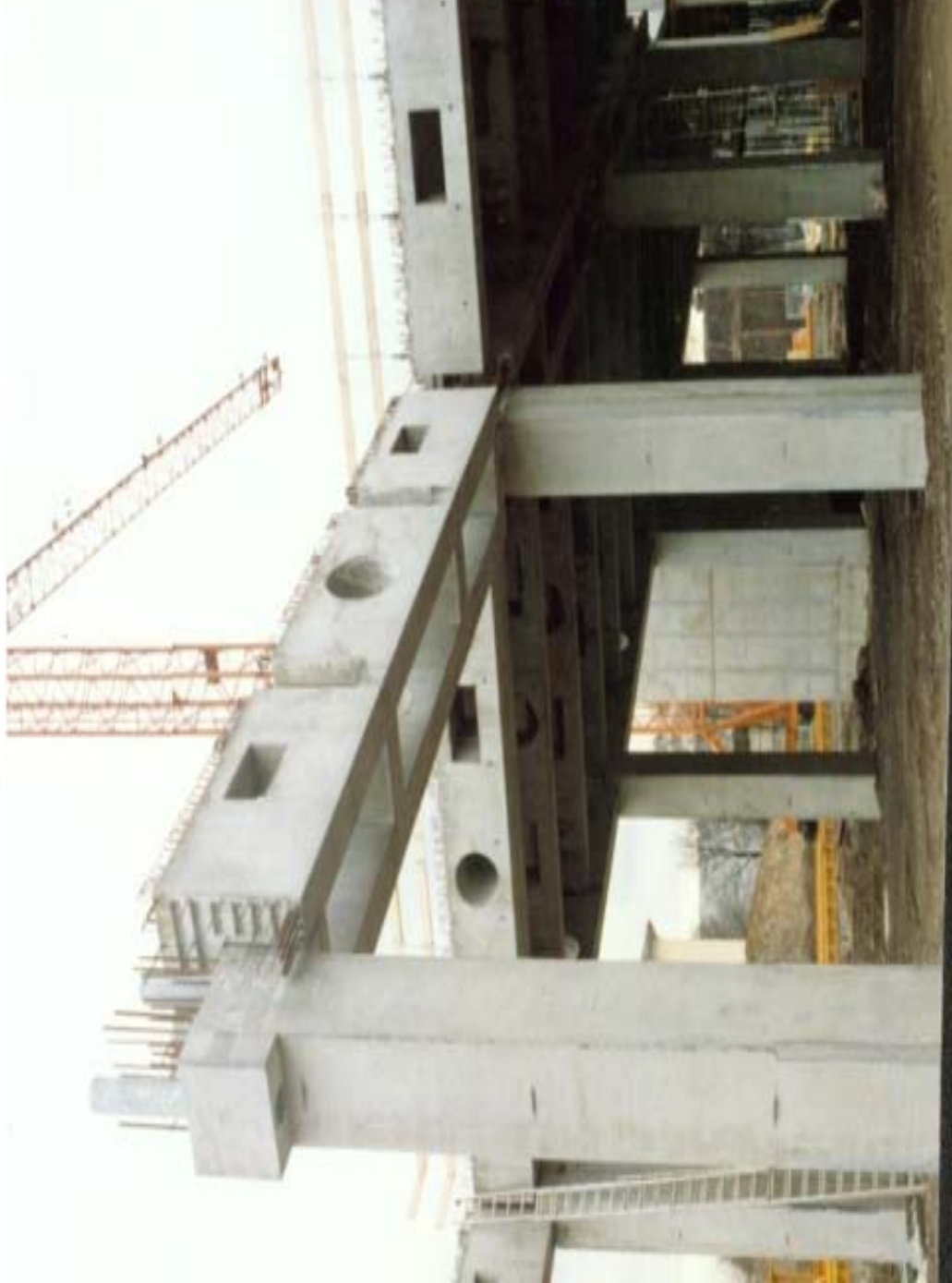
Bild 11: Regelaussparungen Produktionsanlage Automobilindustrie
