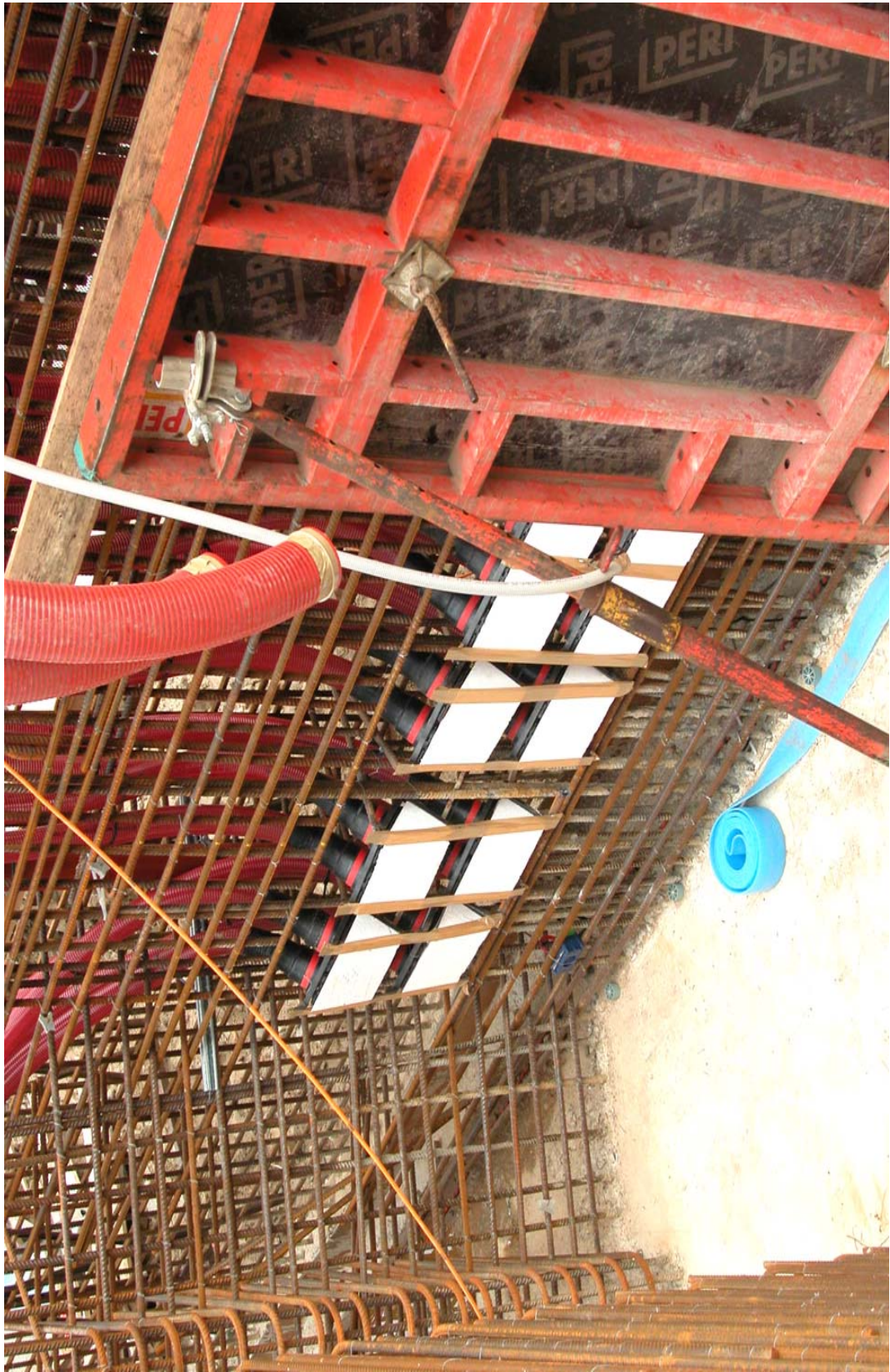
Bild 4: Leerrohre Durchdringung Wandbewehrung
