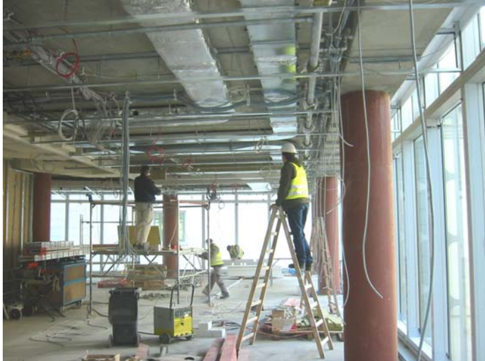
Bild 2: Geschossdecke und laufende Installationsarbeiten
