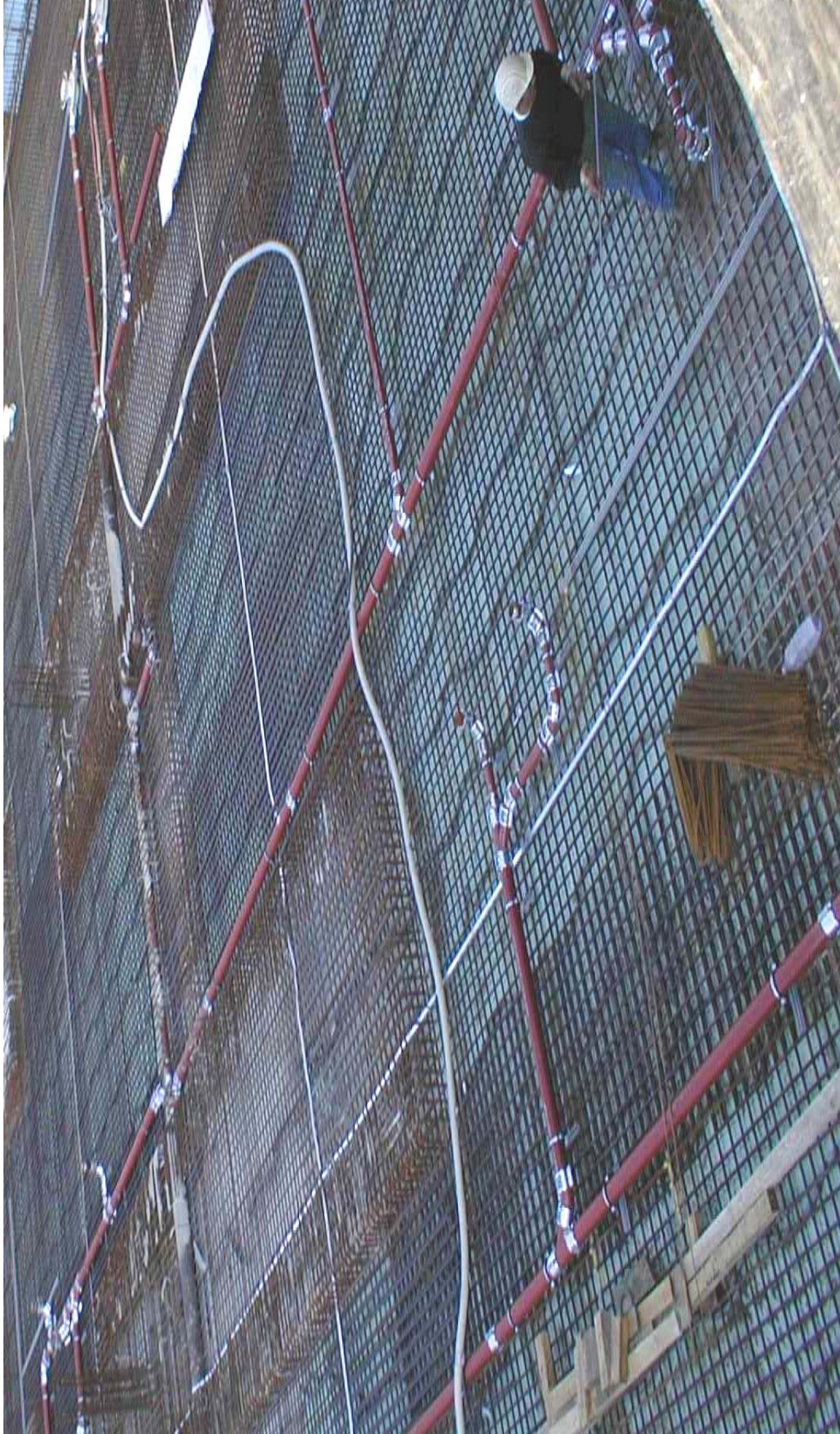
Bild 2: Entwässerungsrohrnetz einer „Weißen Wanne“ in einer Bodenplatte
