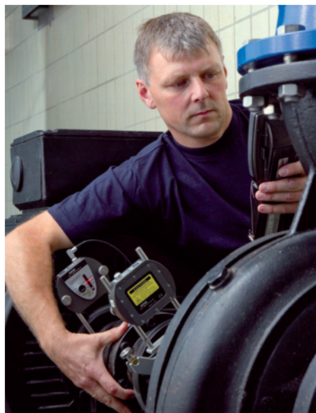
Bild 6: Sorgfalt bei der Installation einer Pumpe zahlt sich immer aus: Eine exakte Ausrichtung von Normpumpen durch laseroptische Messgeräte optimiert den Wirkungsgrad der Pumpen und baut Verschleiß vor.
