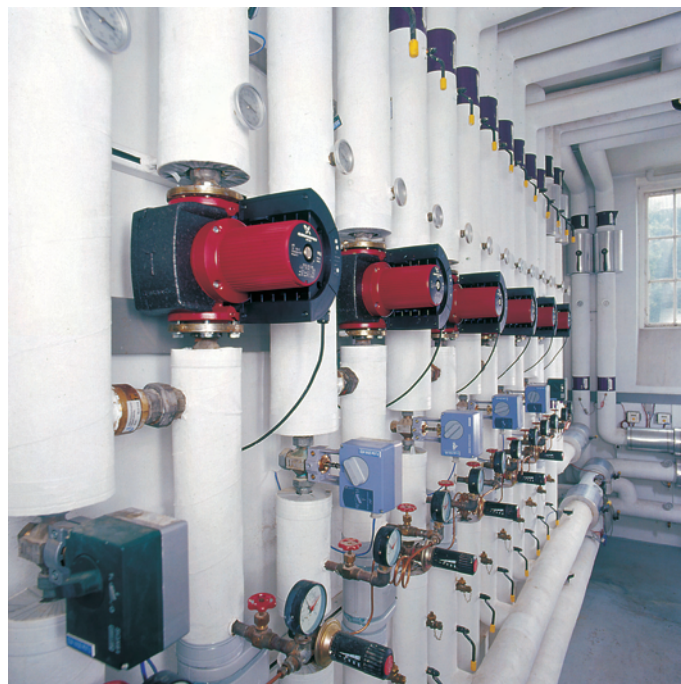
Bild 1: Pumpensysteme als zentrales Herz der Haustechnik-Infrastruktur spielen bei nahezu allen Optimierungsmaßnahmen eine wichtige Rolle.
