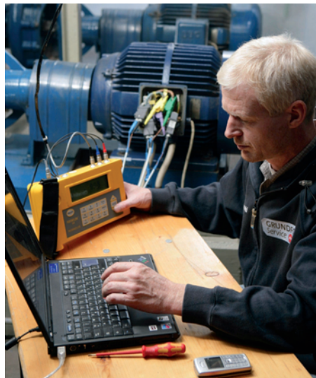
Bild 5: Pump Audit (LCC-Analyse) in einem kommunalen Gebäude.
