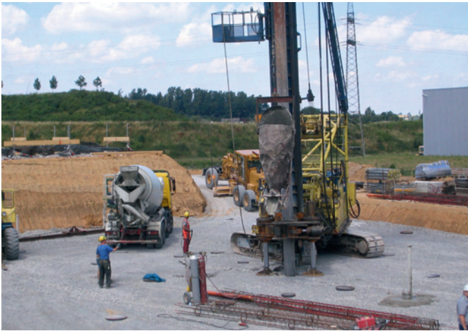
Bild 5: Ortbetonrammpfähle als erdberührte Betonwärmeaustauscher.
