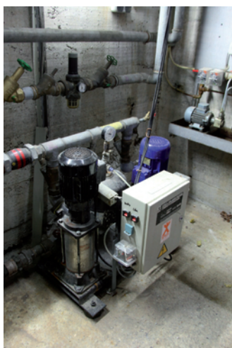
Pumpensteuerung Trinkwasser.
