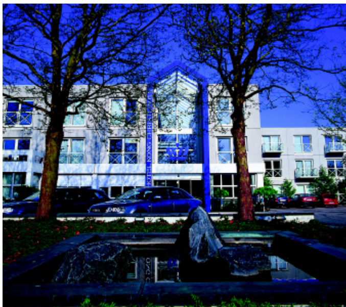
Bild 1: Der ‚Trinkwasser-Hygiene-Check‘ ist für größere Objekte interessant; es geht dabei um die aktive Begleitung des Betreibers einer Trinkwasseranlage auf dem Weg zur TÜV-zertifizierten Legionellen-Prävention (‚Wassergüte-Siegel‘).
