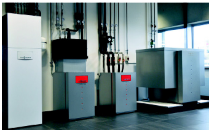
Bild 8: Ein Teil der Vitocal Wärmepumpen, die dazu beitragen, fossile Energie im Werk Allendorf einzusparen.
