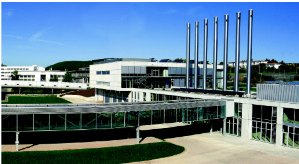
Bild 1: Energiezentrale in Allendorf: „Effizienz Plus“ zeigt, dass mit der heute verfügbaren Technik hohe Einsparungen bei Energie und CO 2 -Ausstoß erzielt werden können.
