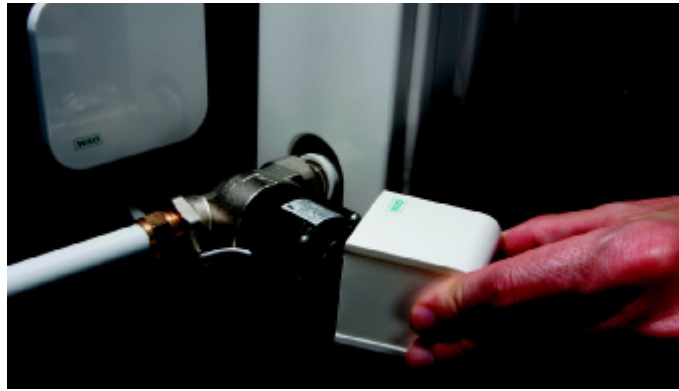
Bild 2: Zentrales Element des Dezentralen Pumpensystems „Geniix“ ist eine neue Generation sehr sparsamer kleiner Pumpen, die so leise sind, dass sie auch in Wohn- und Schlafräumen betrieben werden können. Alle Schallschutzanforderungen werden dabei erfüllt. Der Geräuschpegel liegt deutlich unter dem in der strengsten Stufe III der VDI-Richtlinie 4100 „Schallschutz von Wohnungen“ festgelegten Grenzwert von 25dB(A). Wilo setzt dabei auf die von den Hocheffizienzpumpen bekannte, stromsparende EC-Motortechnologie.
