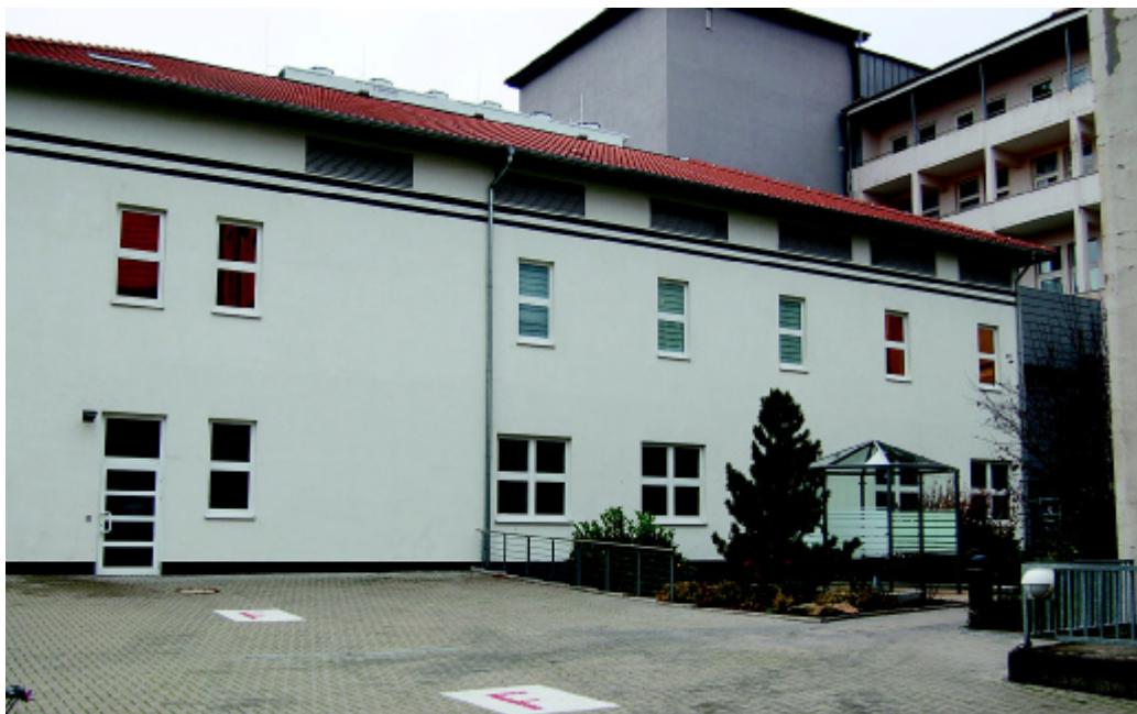
In einem angegliederten Gebäude des St. Marienhospital in Hamm wurden vier neue OP-Säle geplant und umgesetzt. Im Vordergrund standen Hygiene, Energieeffizienz und Minimierung der Schnittstellenproblematik zwischen den ausführenden TGA-Gewerken.
