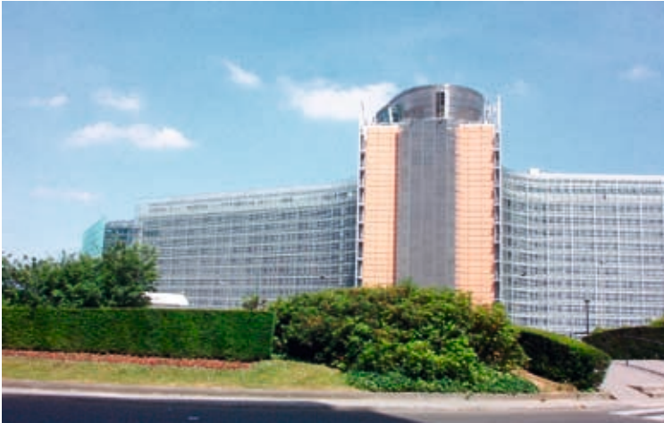
Das Berlaymont-Gebäude in Brüssel ist der Hauptsitz der Europäischen Kommission. Der Verwaltungsbau aus den 60-er-Jahren wurde in den letzten Jahren umfassend energetisch saniert. (Foto: BD Dipl.-Ing. H.-D. Hegner, BMVBS, Berlin)
