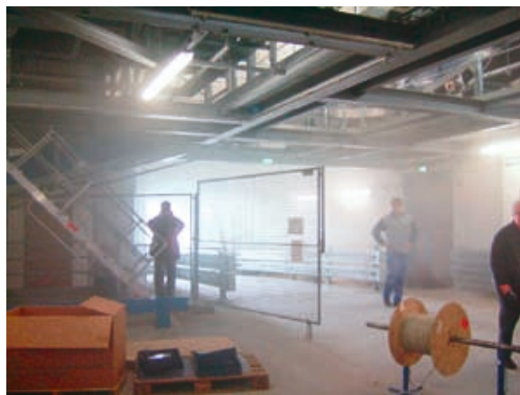
Bild 6: Verrauchung der Zuluft durch Ansaugen von Brandrauch.
