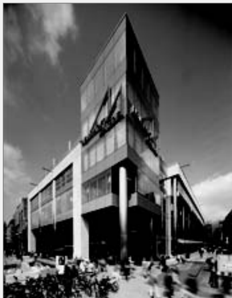
Neumarkt Galerie Köln (Gebäudetechnik)
