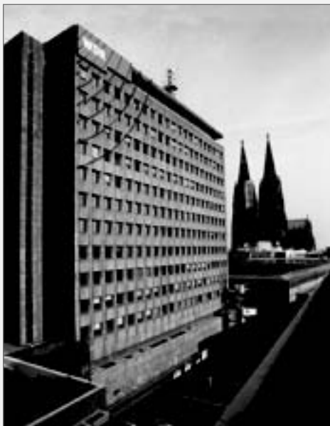
WDR Köln, Archivhaus (Komplettsanierung)
