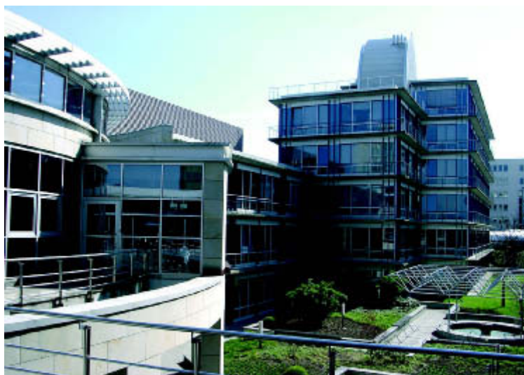
Bild 1: Der DSV erhält ein integriertes Gebäudemanagement
