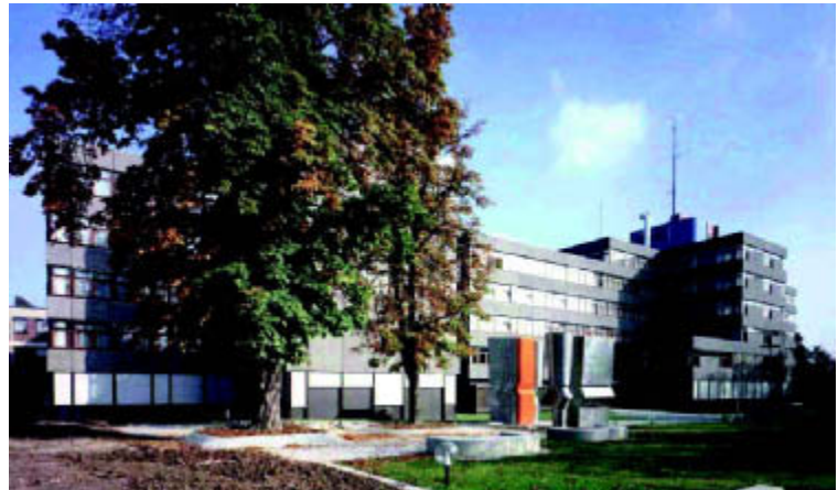
Bild 3: Anpassung der Gebäudeautomation an die sich verändernden Anforderungen im Landeskriminalamt Baden-Württemberg.
