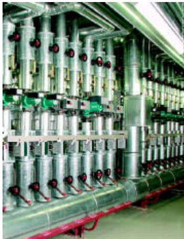
Bild 7: Mehrpumpensystem zur Versorgung von Verbrauchergruppen.
