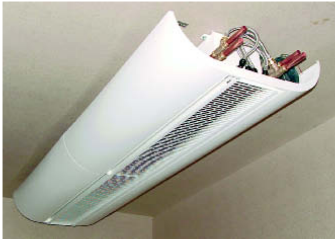
Bild 14: Aktiver Deckenkühlkonvektor mit Abdeckung der Installationen durch seitliche „Wings“.
