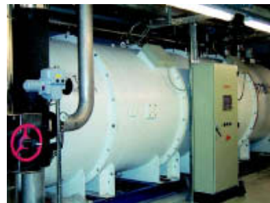
Bild 5: Klimatisierung mit R718-Turbo-KWS in der „Gläsernen Manufaktur“ VW Dresden
