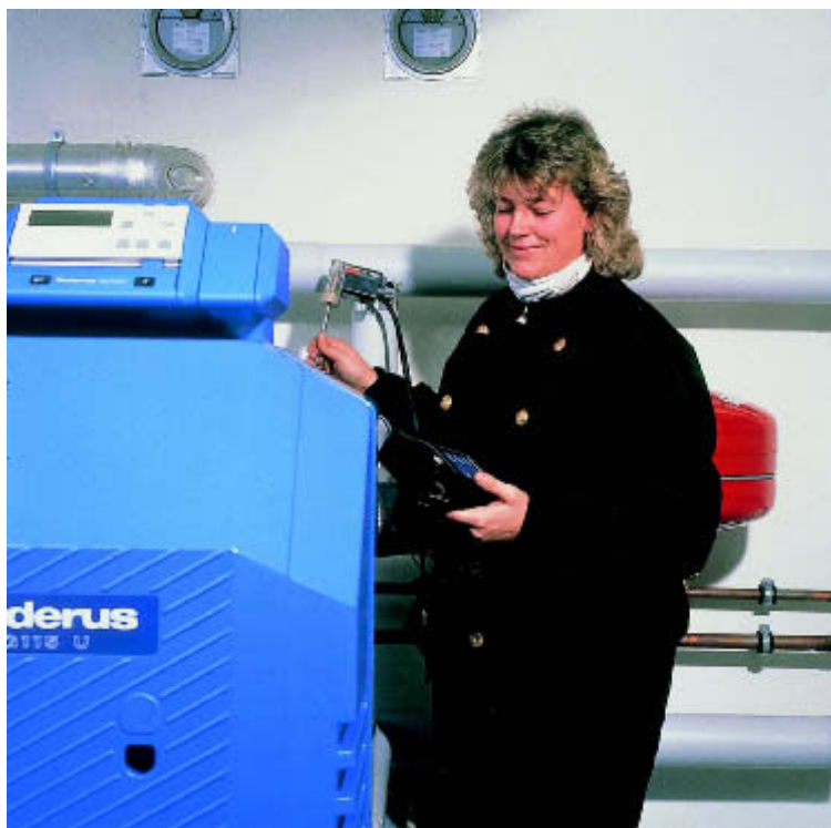
Bild 1: Bestimmung des sensiblen Abgasverlusts im Rahmen der jährlichen Emissionsmessung.
