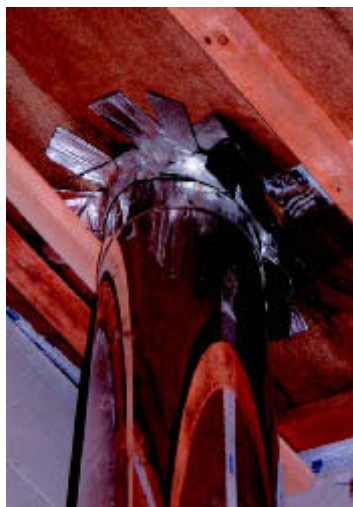
Beispiel einer schlechten handwerklichen Ausführung durch falsche Klebebänder
