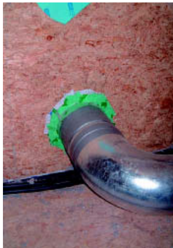
Beispiel einer dauerhaft dicht ausgeführten Abklebung einer Rohrdurchführung
