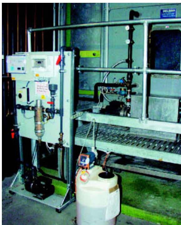
Konventioneller Luftwäscher mit UV-Entkeimungsanlage
