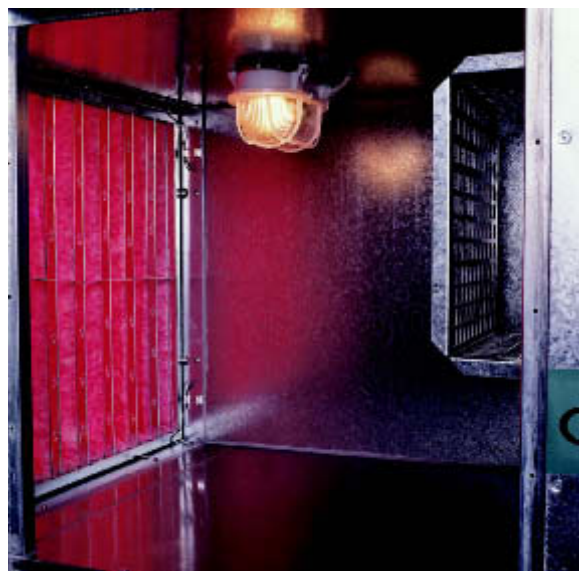
Spezielle Zentrallüftungsgeräte für hoch sensible Bereiche, wie z.B. die Lebensmittelherstellung oder OP-Säle in Krankenhäusern erfüllen aufgrund ihres Aufbaus besonders hohe Hygiene-Standards.
