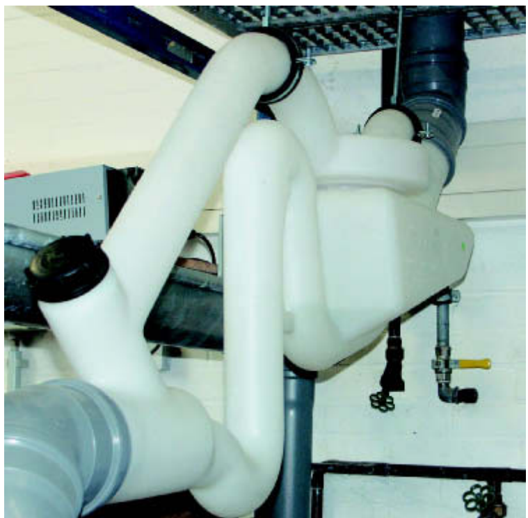
Bild 2: Abflussverstärker (Modellanlage am Inst. f. Wassertechnologie der FH Braunschweig/ Wolfenbüttel)
