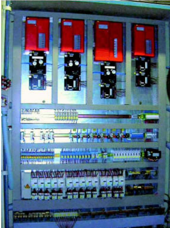
Bild 3: Sanierter Schaltschrank mit DDC-Controllern
