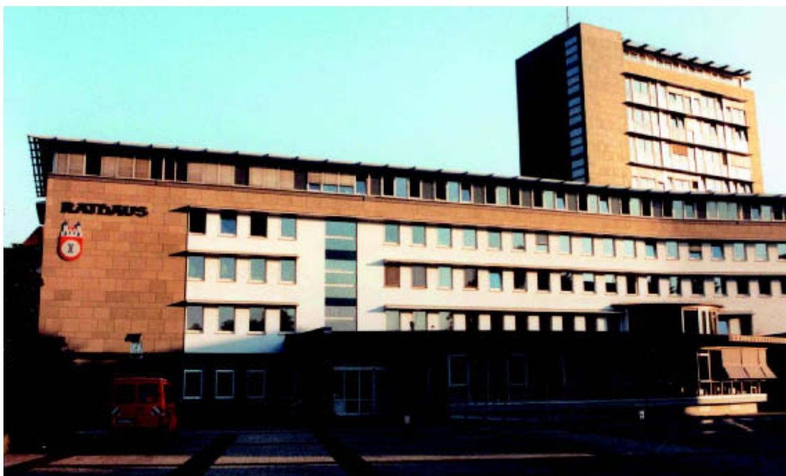
Rathaus der Stadt Hameln: Vom Hochbauamt werden derzeit 41 Liegenschaften der Stadt Hameln über die fabriksneutrale Gebäudeleittechnik IBS überwacht und bedient.
