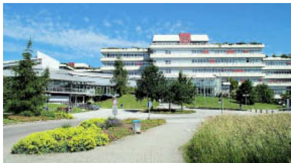
Bild 1: Außenaufnahme der Uni Ost von Süden
