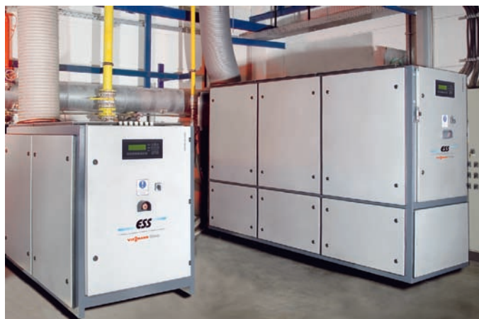
Bild 4: Die mit Erd- oder Biogas betriebenen Vitobloc 200 der zur Viessmann Group gehörenden ESS GmbH sind derzeit Leistungen bis 401 kW el und 549 kW th lieferbar.
