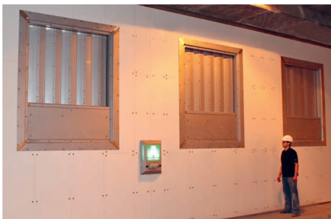
Eingebaute Tunnelklappe, Elbtunnel Hamburg.
