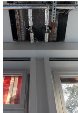
Abb. 4: Insgesamt 99 „GeniAx“-Pumpen wurden im Anbau der Schule installiert. Sie sind über Pumpenadapter in der Ausführung Durchgang in das erneuerte Leitungsnetz eingebunden. Seit September 2010 erfolgt auch im Altbau die Wärmeverteilung durch das Dezentrale Pumpensystem „Wilo-GeniAx“. Dort kommen 90 Pumpen und 31 Raumtemperatursensoren zum Einsatz.
