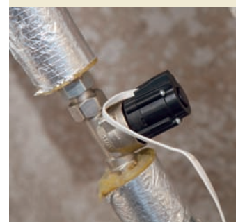
Abb. 4: Insgesamt 99 „GeniAx“-Pumpen wurden im Anbau der Schule installiert. Sie sind über Pumpenadapter in der Ausführung Durchgang in das erneuerte Leitungsnetz eingebunden. Seit September 2010 erfolgt auch im Altbau die Wärmeverteilung durch das Dezentrale Pumpensystem „Wilo-GeniAx“. Dort kommen 90 Pumpen und 31 Raumtemperatursensoren zum Einsatz.
