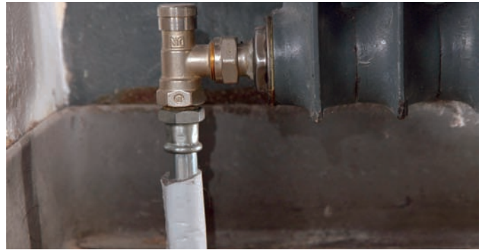
Abb. 6: An den Heizkörpern befinden sich keine frei beweglichen oder werkzeuglos demontierbaren Teile mehr – ein wichtiger Vorteil, um unerwünschten Eingriffen vorzubeugen.
