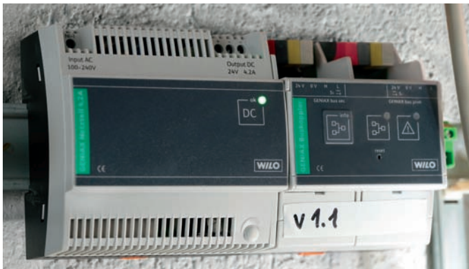
Abb. 8: Verstärkereinheiten, bestehend aus Buskoppler und Netzteil, teilen das gesamte System in mehrere Segmente auf, um eine größere Betriebssicherheit zu gewährleisten. Dank Buskopplern lassen sich komplexere Busnetze realisieren wie sie in Großobjekten, wie beispielsweise Schulen, vorkommen.
