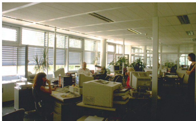
Außenraffstore mit Tageslichttransportelement. Durch einen separaten Stellwinkel der Lamellen im oberen Bereich des Behangs wird der Raum mit Tageslicht beleuchtet, obwohl der Raffstore darunter geschlossen ist. Hier wurde der Behang nicht ganz hinuntergefahren, damit der Sichtkontakt ins Freie bestehen bleibt.
